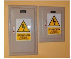
EL TABLERO ELÉCTRICO, EN GABINETE METÁLICO O DE RESINA, DEBE ESTAR SEÑALIZADO Y CONTAR CON LLAVES GENERALES, DE ILUMINACIÓN, DIFERENCIALES Y TERMOMAGNÉTICOS, IDENTIFICADO CON DIRECTORIO DE CIRCUITOS ELÉCTRICOS.
